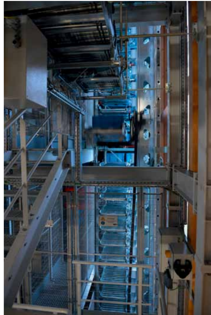
Kernstück der Anlage ist ein Shuttle-Lager mit 19.000 Stellplätzen und 36 Ebenen
