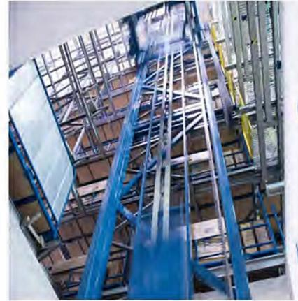
5 Einer der vier Etagenförderer, die als vertikale Verteileinrichtung fungieren und die Rollpaletten über Aufnahme- und Abgabestellen in die verschiedenen Ebenen des Lagers befördern.
