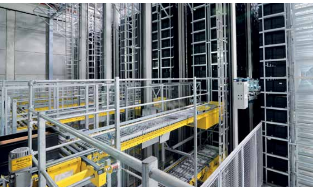
Die sechs Regalbediengeräte des Automatischen Kleinteilagers (AKL) sind nun auf dem neuesten Stand der Technik.
