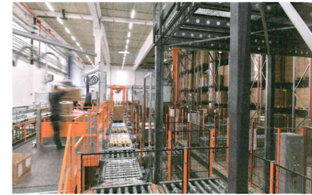
Bild 2 Die Kommissionierung erfolgt nach dem Ware-zum-Mann-Prinzip. Bilder: SITLog
